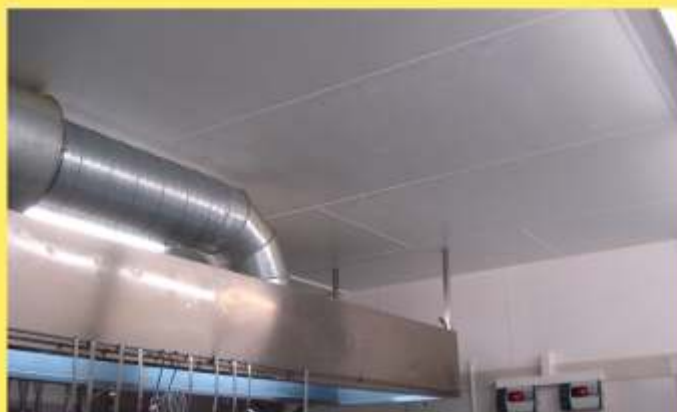
Küche: Wand, Decke, Küchenrückwand abwaschbar, fugenlos
