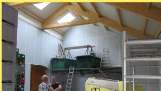
Abwaschbar gedämmt -> keine Kondensationsfeuchte
