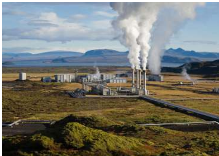
Das Nesjavellir-Kraftwerk ist das größte Geothermalkraftwerk Islands. Es produziert derzeit 120 MW elektrische Leistung und etwa 1800 Liter/Sek. heißes Wasser (300 MW).
