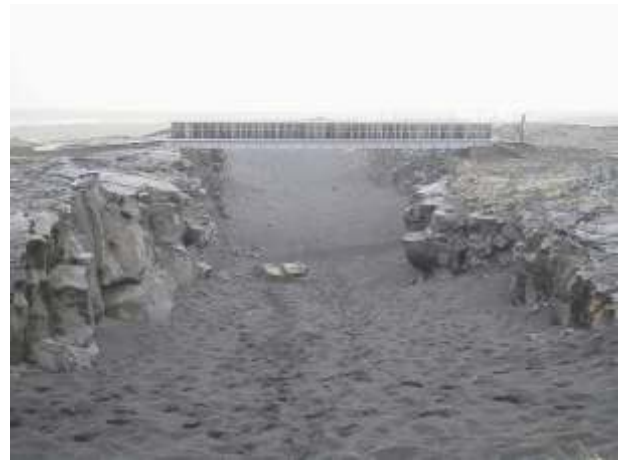
Diese Brücke auf der Halbinsel Reykjanes im Südwesten Islands muss sich durch die tektonische Plattenverschiebung um jährlich 2 cm anpassen. Diese unvorstellbar große Energie im nahen Erdinneren wird die weitere Verschiebung der Platten durch die zahlreichen Schlösser, die Liebespaare anbringen, nicht einmal symbolisch verhindern können.
