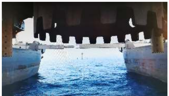
Sobald die Hubarme positioniert sind, werden die Plattformsteher durch autogenes Brennschneiden zähneartig getrennt und anschließend gehoben.
