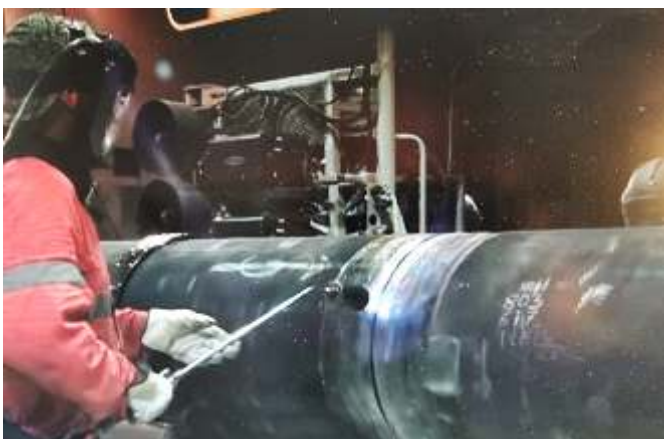
Die Verschweißung der Rohre erfolgt mehrfach und gleichzeitig an Bord.
