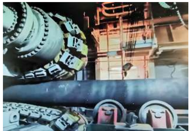
Mehrere Raupen sind für den gleichmäßigen Transport der fertiggeschweißten Pipeline verantwortlich.
