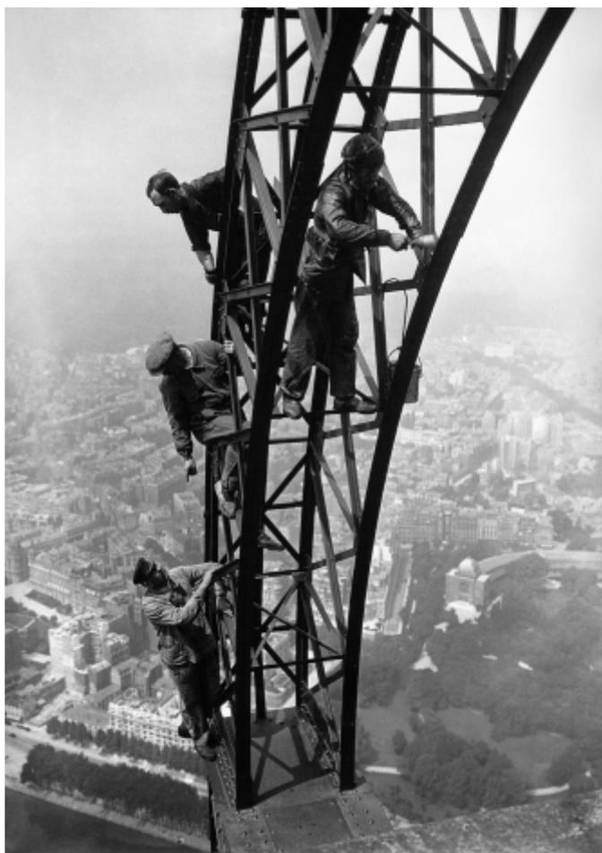
*Bisher wurde der gesamte Turm mit seinen 250.000 m<sup>2</sup> Fläche ganze 19 Mal gestrichen (Foto von 1924). Jeweils 60 Tonnen Farbe werden pro Neulackierung aufgetragen.*
