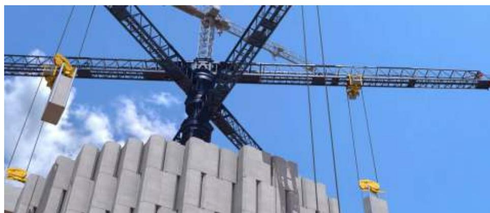
sechsarmigen Krans werden tonnenschwere Betonblöcke rund um den Kran aufgestapelt. Ähnlich dem Speicherkraftwerk werden während der energiereichen Zeit die Blöcke aufgebaut, zu Spitzenstromzeiten werden die Blöcke hergelassen
